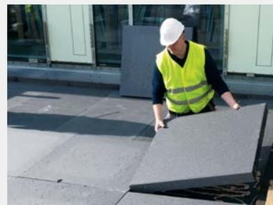
▲ Verlegung von EPS-Platten auf einem Vordach
