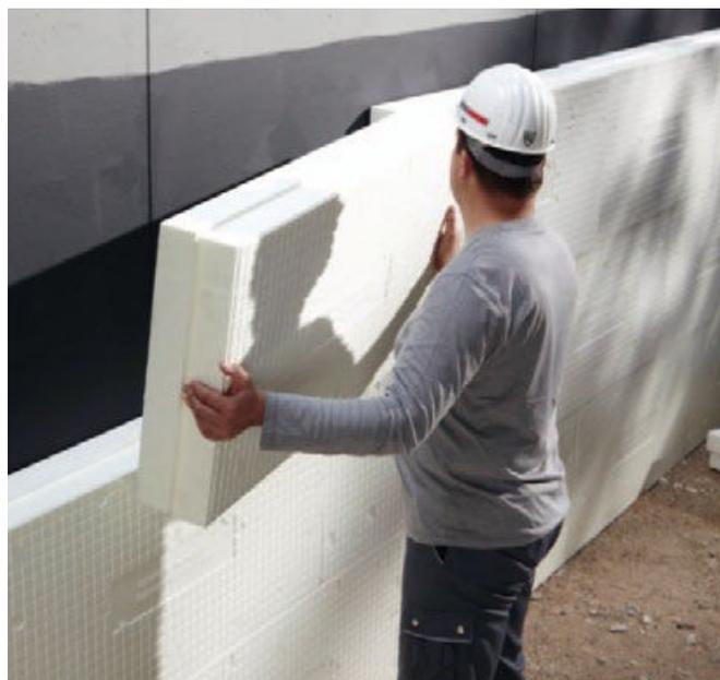
Abb. 2: Gemäß Energie-Einsparverordnung müssen Außenwände und Fußböden beheizter Kellerräume ebenso wie Wände gegen unbeheizte Räume wärmegeklämt sein. Dies gilt auch für selten beheizte Kellerräume, wie z.B. Hobbyräume.
