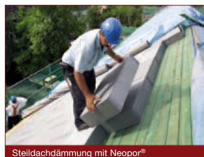
Steildachdämmung mit Neopor®
