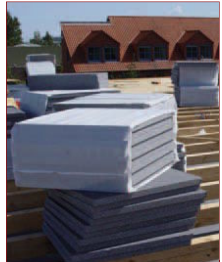
Im Freien gelagerte Pakete mit Dämmplatten aus Neopor® in opaker Folie
