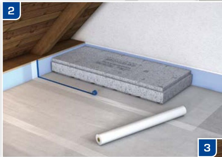
**Zu 2:** Falls erforderlich, muss eine Dampfbremse verlegt werden. Die Dampfbremse wird an der Wand oberhalb der Kante des Fertigfußbodens befestigt. Achtung: bitte auf Überlappung und saubere Nahtverklebung der Folie achten. Randstreifen befestigen. Mit der Verlegung der ersten ESB Granit-Platte in einer Raumecke beginnen.
